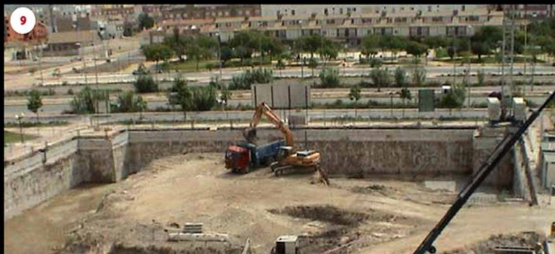
1. Excavación de batache con cuchara bivalva. - 2. Central de lodos bentoníticos. - 3. Utilización de trépano en terrenos excesivamente duros, o en roca. - 4. Armado del batache. - 5. Vertido de hormigón mediante tubo tremie. - 6. Extracción tubo de juntas con gato hidráulico. - 7. Bataches terminados del muro pantalla. - 8. Ejecución viga de unión, nivelación y coronación. - 9. Excavación y vaciado.
