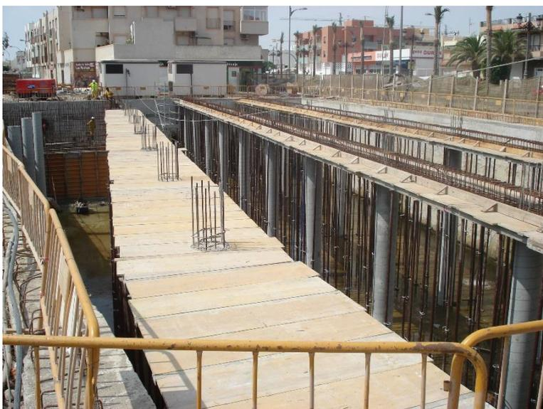
Foto 2 – Construcción del forjado de tapa
