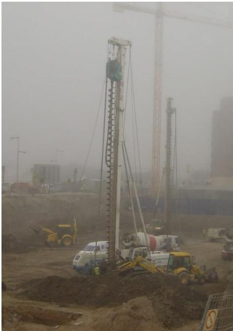
Foto 1 – Ejecución pilotes de 450 mm
