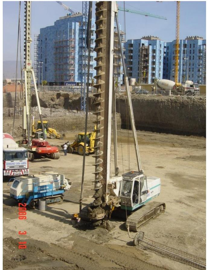
Foto 2 – Ejecución pilotes de 650 mm
