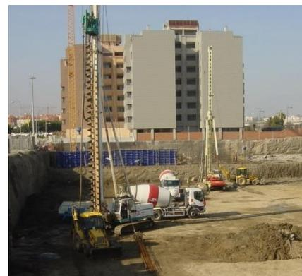
Foto 4 – Ejecución pilotes de 550 mm
