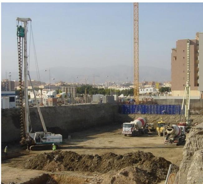
Foto 3 – Ejecución pilotes de 550 mm
