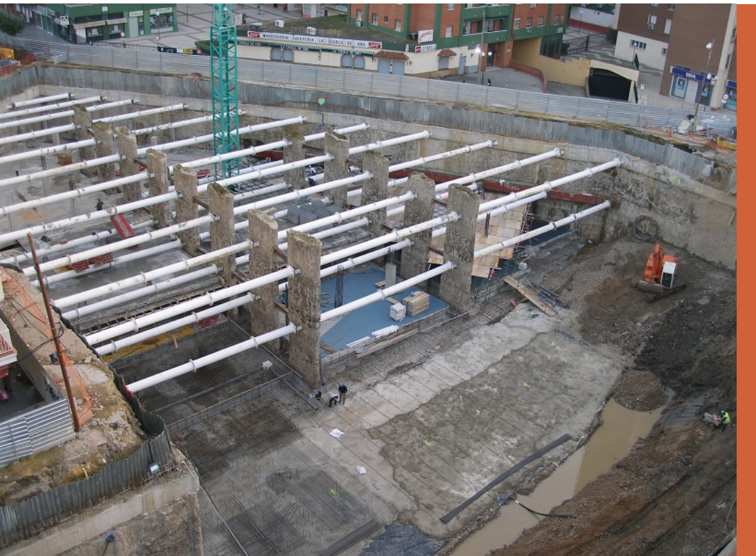
Aparcamiento subterráneo José Laguillo (Sevilla) 3 plantas de sótano Cliente: AZVI
