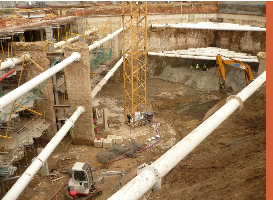
Aparcamiento subterráneo Triana (Sevilla)
