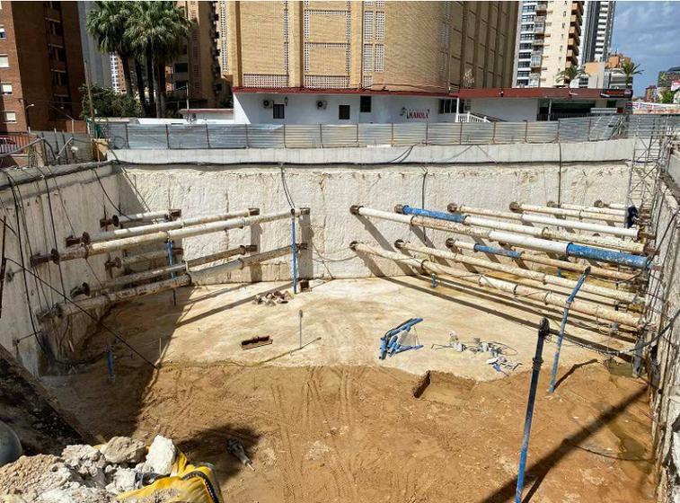
El ámbito de empleo del sistema de arriostramiento metálico incluye a cualquier tipo de obra (edificación y obra civil) en la que se ejecute un muro pantalla en cualquiera de sus variantes (muro pantalla continuo de pilotes o micropilotes) y que por su geometría sea factible la colocación de un arriostramiento metálico
